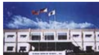
Hitachi Air Conditioning, Филиппины
