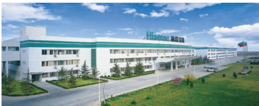
Hisense (Shandong) Air Conditioner Ltd., г. Циндао
