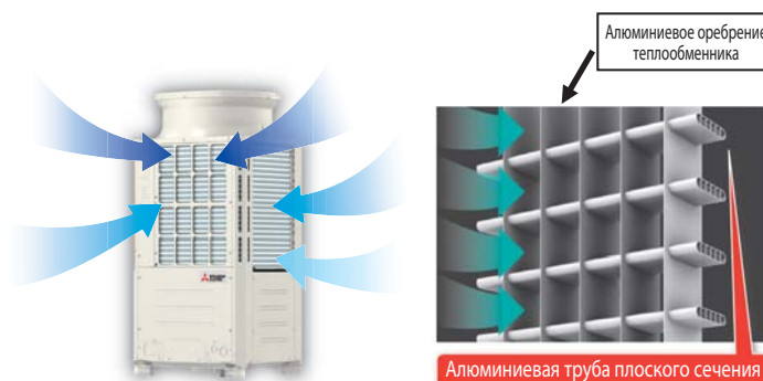
Четырехсторонний теплообменник
