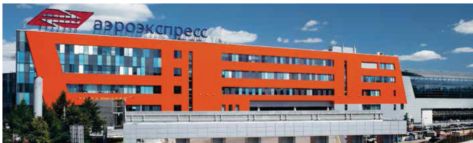
ООО «АЭРОЭКСПРЕСС», г. Химки
