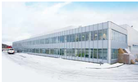
Производственно-складской комплекс «ДÉЛЕР НФ И БИ», г. Лобня
