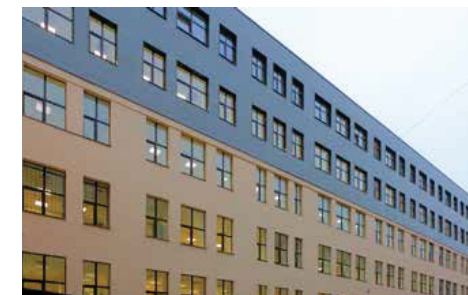
Административно-офисное здание «Тайм-центр», г. Москва
