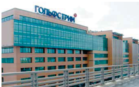
Офисный центр «Гольфстрим», г. Москва
