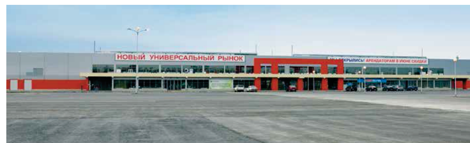
Муниципальный рынок, г. Рязань
