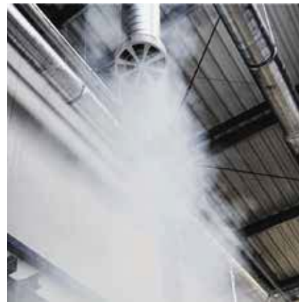
Рис.1: Вертикальное распределение воздуха.
